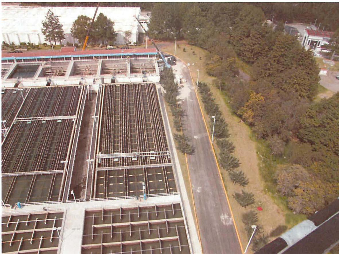
*“Acciones realizadas - Modernización del sistema de filtración de la planta potabilizadora Los Berros, Sistema Cutzamala, trabajos de colocación del bajo dren (boquillas por debajo dren Leopold) en módulos existentes en la planta potabilizadora de Los Berros del Sistema Cutzamala, Estado de México”*
