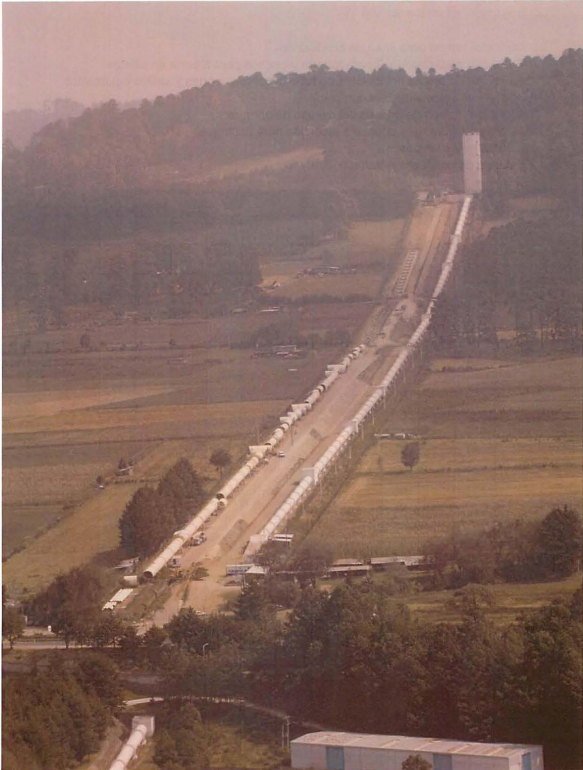
*"Acciones realizadas - Construcción de la 2a. línea de alta presión de la planta de bombeo No.5 a la torre de oscilación No.5, Sistema Cutzamala, Estado de México"*
